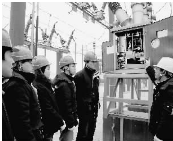
河南修武县电业局变电检修部通过传帮带迅速培养新进员工,使他们能尽快进入角色。图为3月3日,该公司变电检修部杜东升正在现场为青工讲解六氟化硫开关的结构原理。李建强 摄
